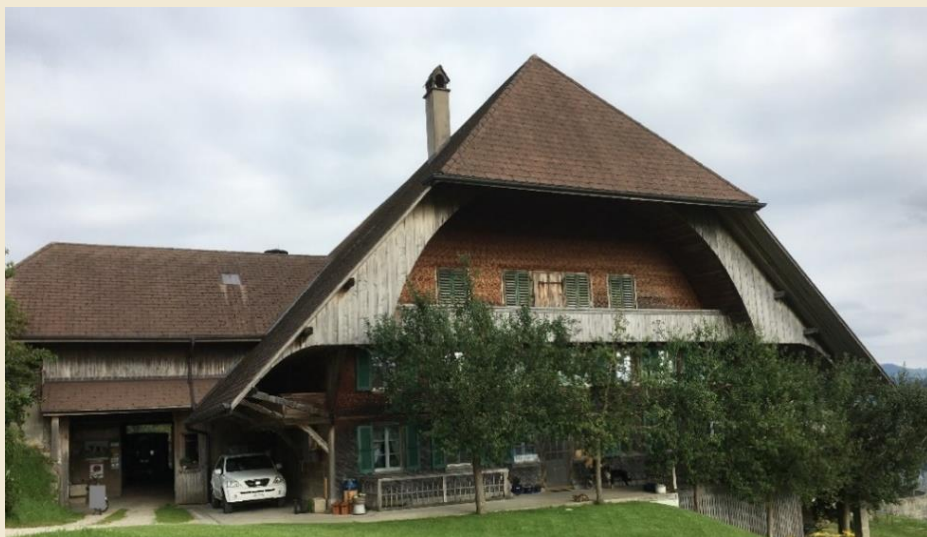
Ferme sur la Dürsrüti (nouvelle construction après un incendie au 18e siècle)
